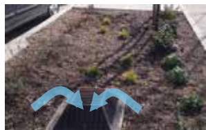
オーバーフロー用の設備
